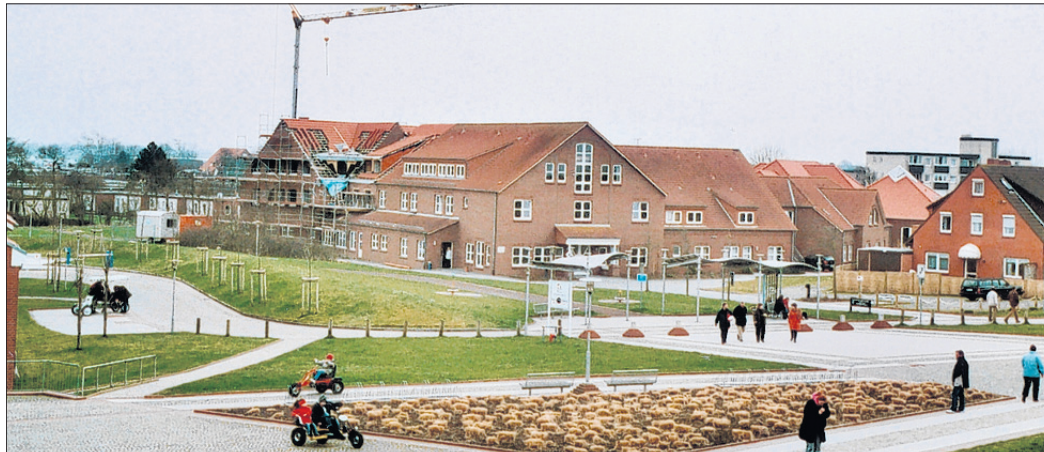
Die Bauarbeiten am Therapiezentrum für Mutter und Kind in Norddeich sind jetzt abgeschlossen.
